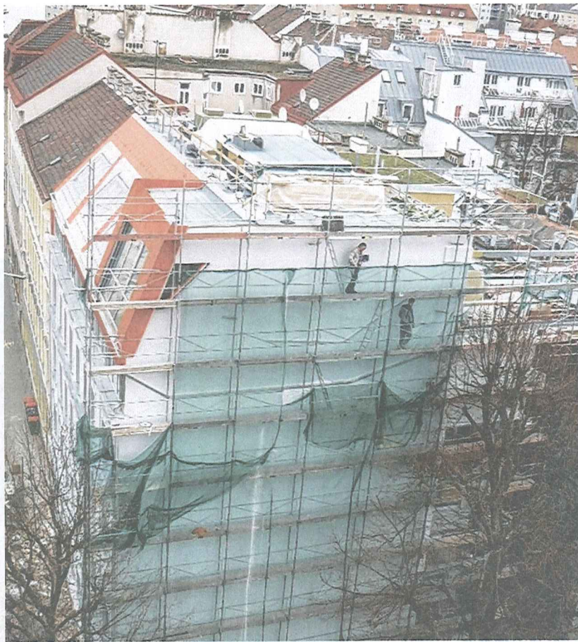
Fassadensanierung und Dachausbau machen aus einem Substandardhaus in Wien ein Energiespar-Modellprojekt
